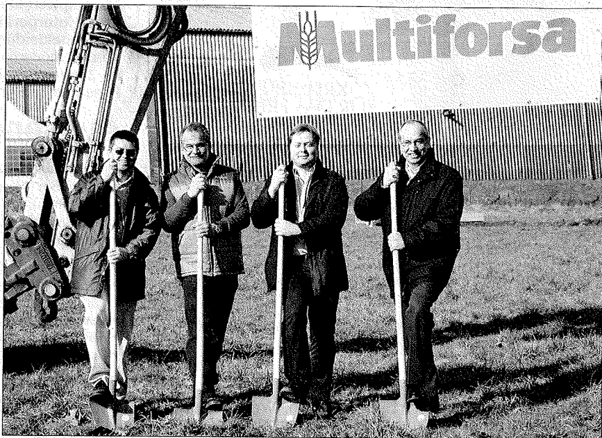
Mit neuen Zukunftsperspektiven: von links Mark Bonorand (Vertreter der Bauherrschaft), Andreas Santschi (Geschäftsführer Multiforsa AG), Philipp Bonorand (Vertreter der Bauherrschaft) und Peter Forster (Verwaltungsratspräsident Multiforsa AG) vollziehen den offiziellen Auftakt des Bauvorhabens
